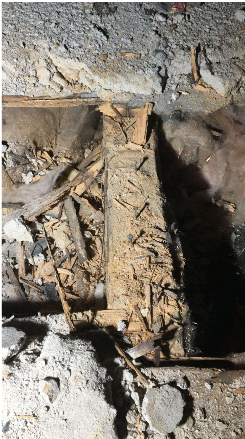
Kleština poškozená hnilobou
