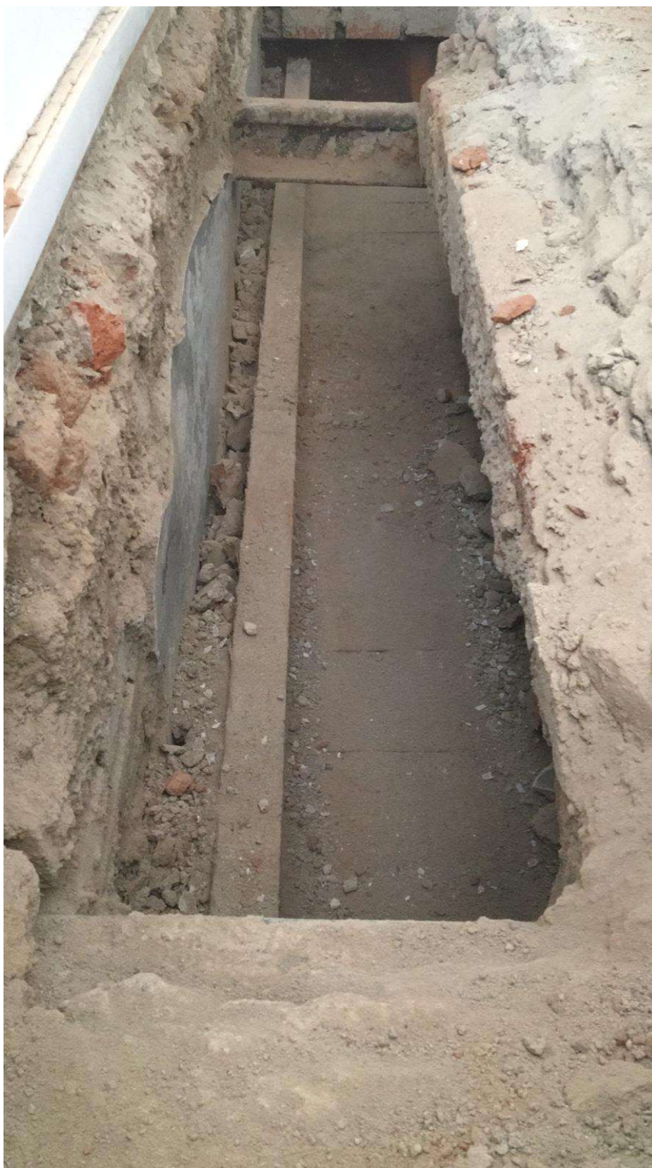
Strop nad 2.NP – klenby do kolejnic a konstrukce podhledu
