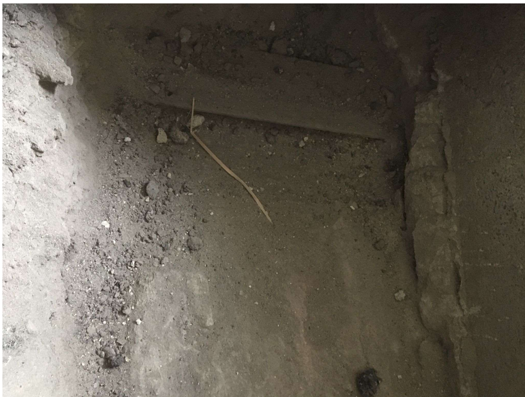
Sonda stropní konstrukce nad 1.NP – horní příruba I nosníku a horní líc valené klenby
