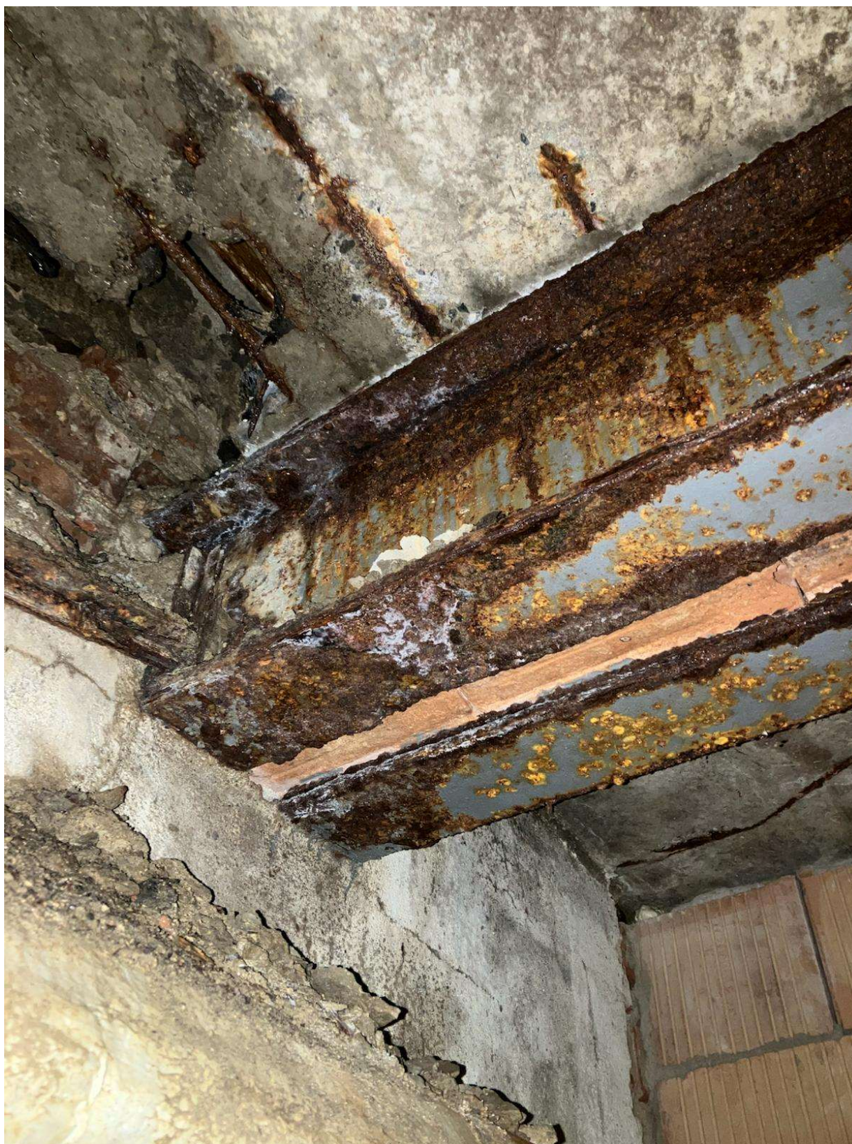
Stropní panel a ocelový průvlak nad sklepem v 1.NP – koroze výztuže stropních panelů a koroze ocelových nosníků
