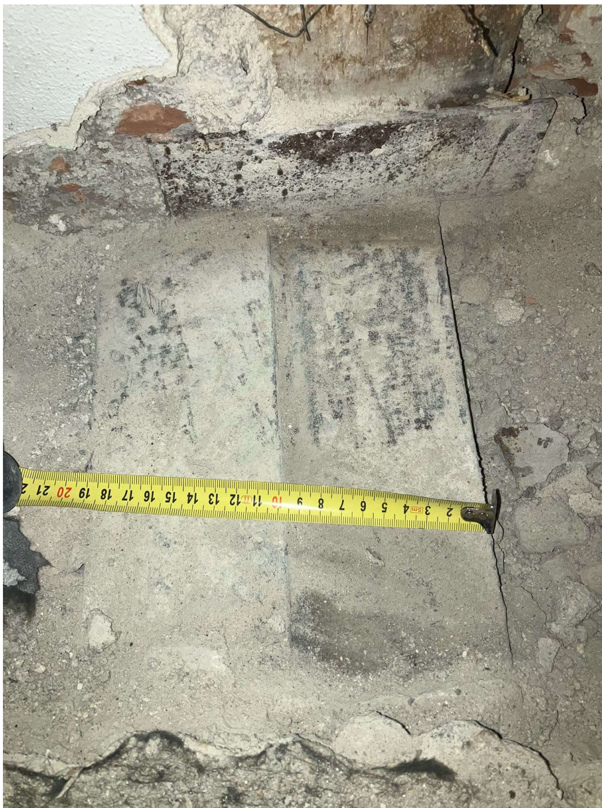
Uložení sloupku krovu na ocelové nosníky
